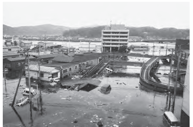
津波到来後の旧本庁舎周辺
