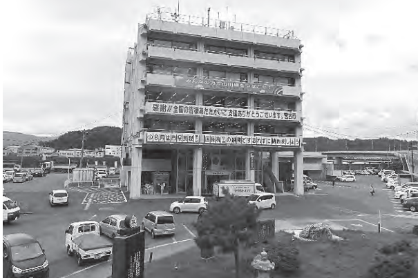
旧本庁舎全景
