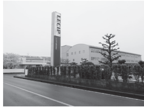
第4工場の全景
