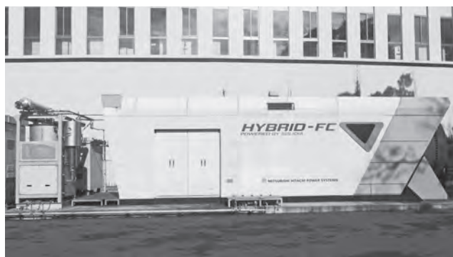
燃料電池SOFCとマイクロガスタービンの合計で出力220kWのハイブリッド発電システム
